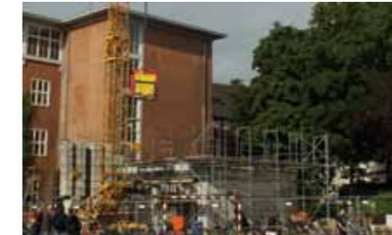
Der neue Anbau entsteht, 2008
